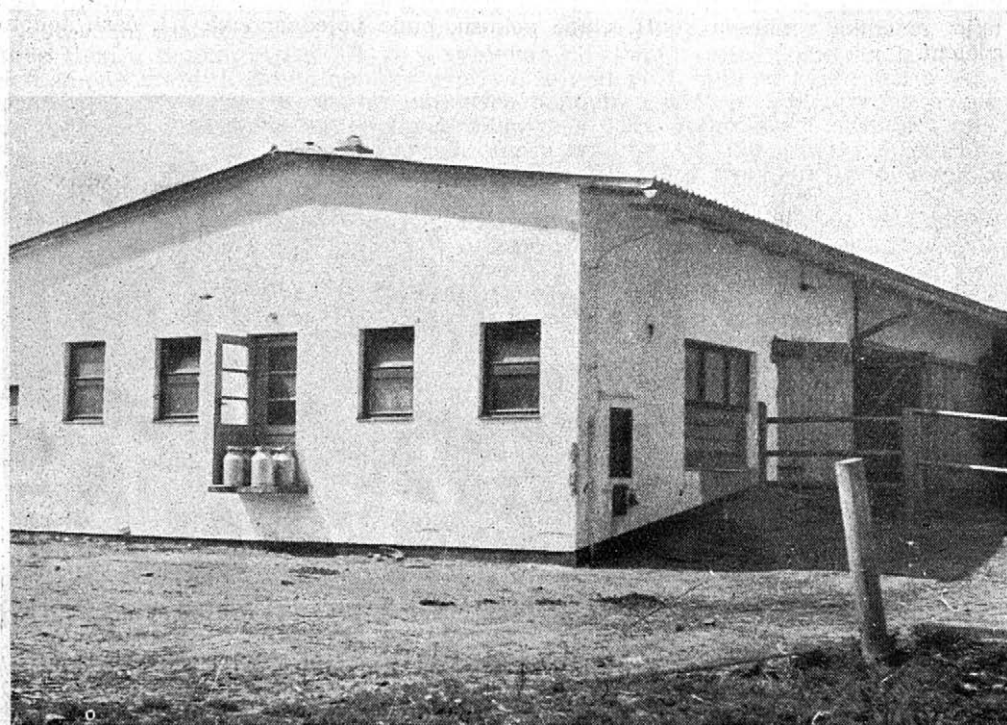
2. Pohled na dojírnu volné stáje pro dojnice ve VÚŽV
